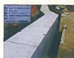
施工完了 (曲線部も直線部と同じ施工)
