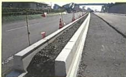
撮影日:平成25年08月 製品名:歩車境界ブロック 可成土木事務所 原田道路新設改良248号
