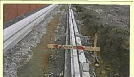
撮影日:平成26年03月 製品名:地先境界ブロック 福岡県水巻町役所 和田・井地間線外道路改築工事
