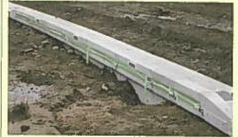
完了日:平成25年03月 製品名:兵庫型L型割溝ブロック 兵庫県養父土木事務所 植木山開通道路改良工事その2
