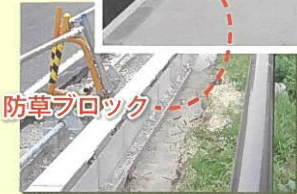
完了日：平成 24 年 08 月 製品名：歩車境界ブロック 名古屋国道事務所 平成 22 年度 22 号枇杷島電線共同溝名西工工事
