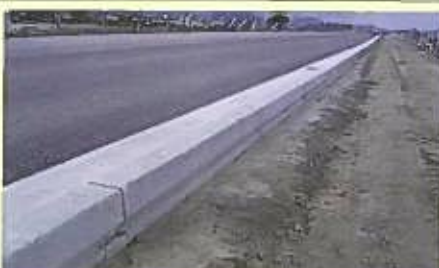
撮影日:平成26年01月 製品名:両面歩車境界ブロック 北九州国道事務所 福岡201号延長地区改築工事
