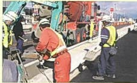
完了日:平成25年02月 製品名:歩車境界ブロック 宇都宮国道事務所 4号国道茨城バイパス舗装工事
