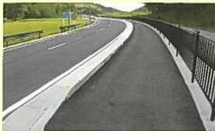
完了日:平成25年07月 製品名:L型割溝ブロック 奈良建設事務所 御日市多度標道路改良(その2)工事
